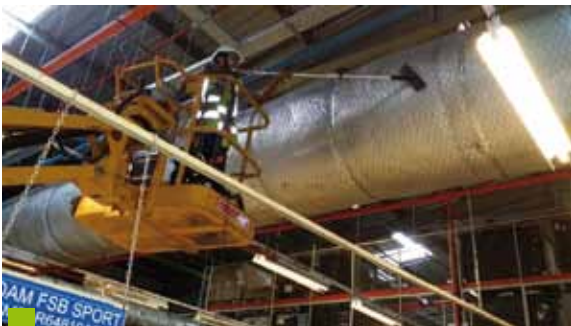
Limpieza en altura de conductos
